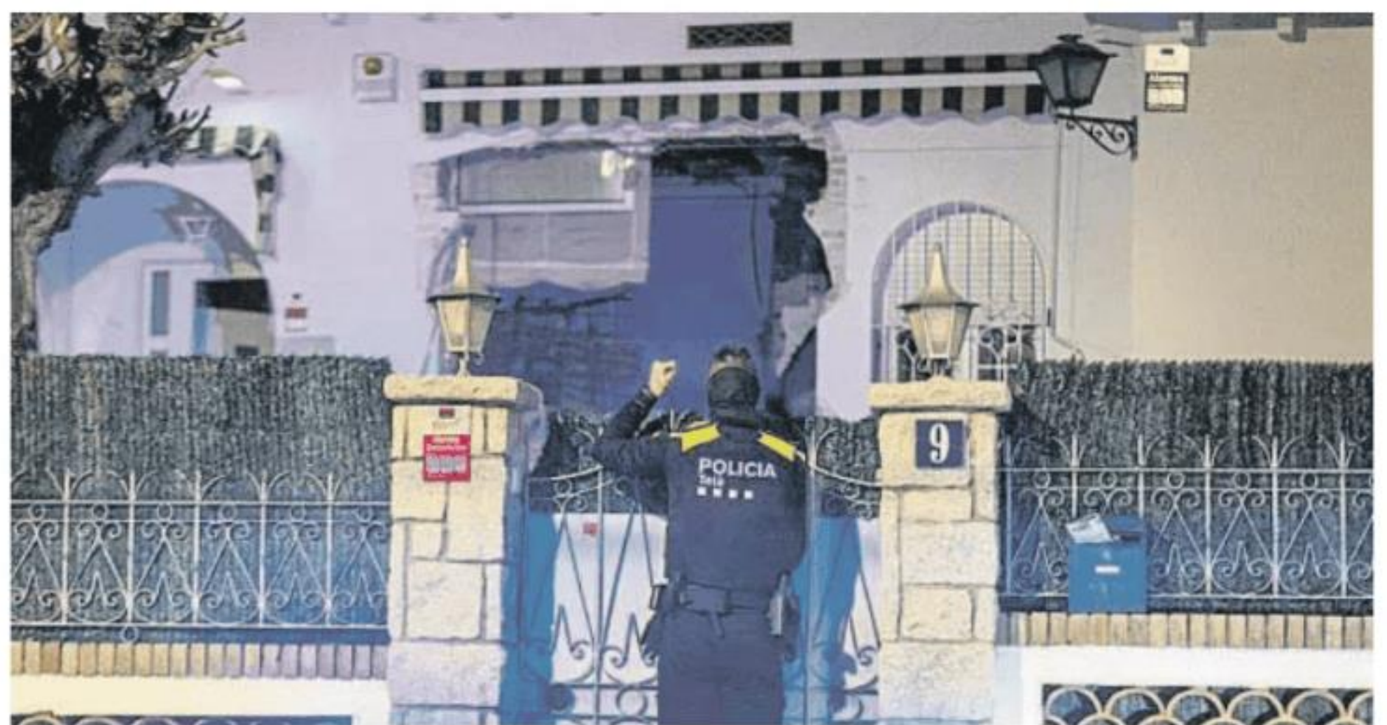
La vivienda siniestrada pocas horas después de la explosión que provocó una víctima mortal
